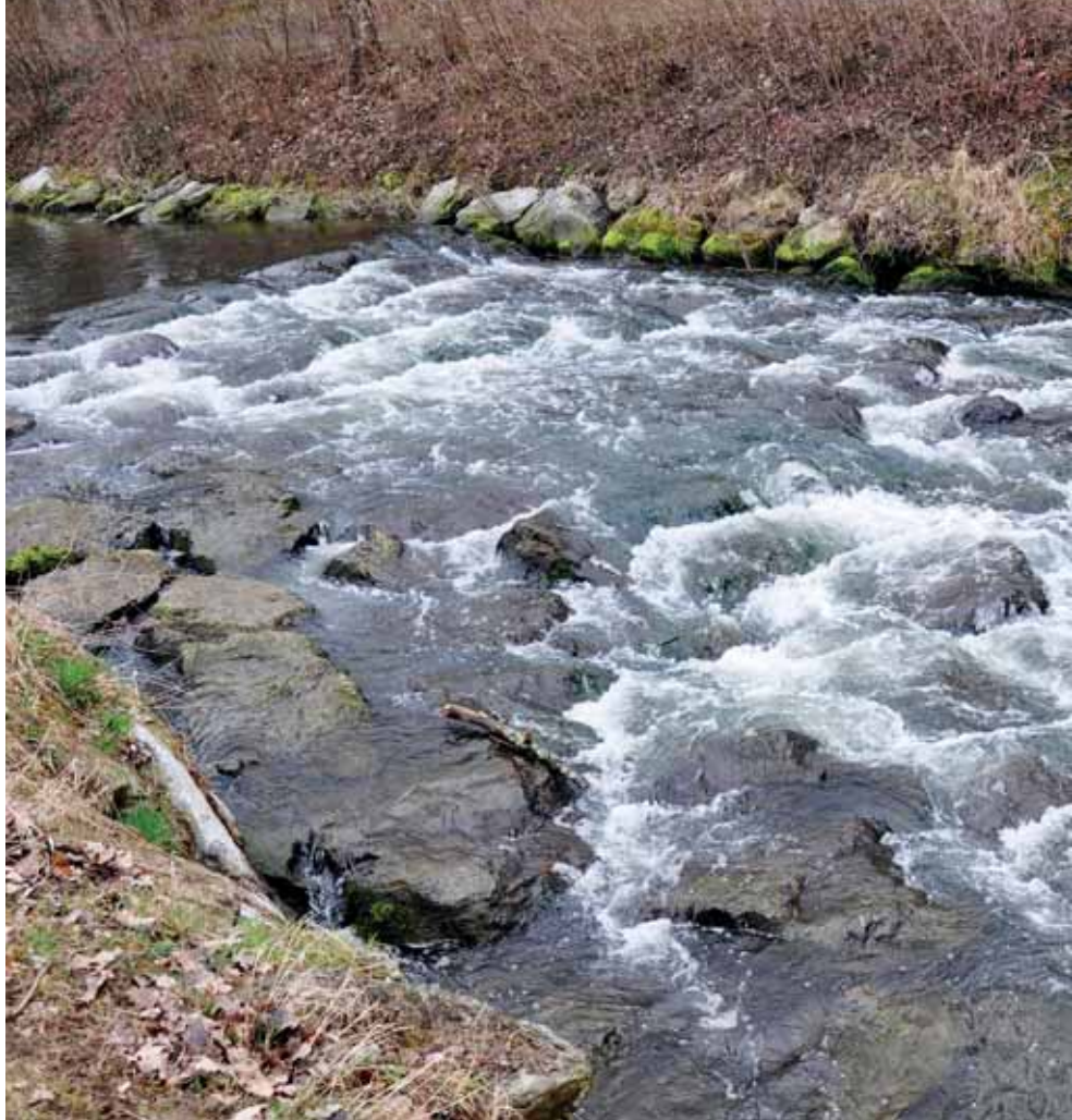
▲ Blockrampe am Aabach in Niederuster, Kanton Zürich.
