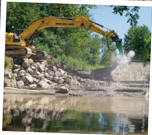
Im Rahmen des Projekts Fluss frei! wird ein altes Mühlenwehr im Talent (VD) rückgebaut. Der Fluss erhält dadurch ein Stück seiner Natürlichkeit zurück.
